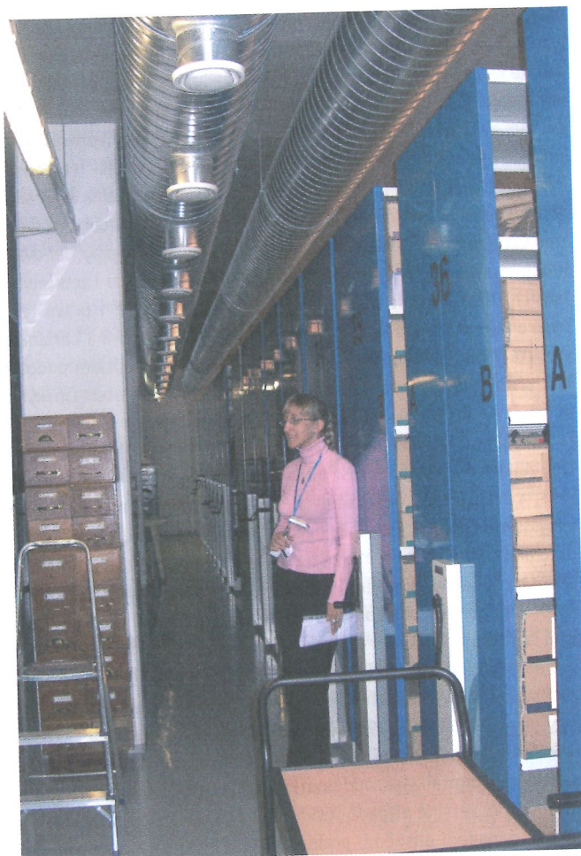
Moderní depozitáře Estonského historického archivu v Tallinu
